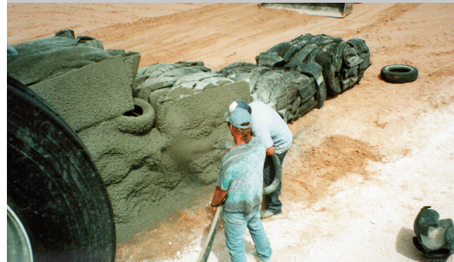
Projetar betão (em húmido) com uma mistura rígida e de baixo assentamento é apenas uma das muitas aplicações para a bomba de betão LS600.
