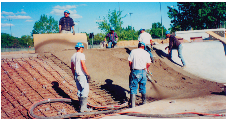
Projetar betão (em húmido) com uma mistura rígida e de baixo assentamento faz parte do quotidiano da C30HD Mayco.
