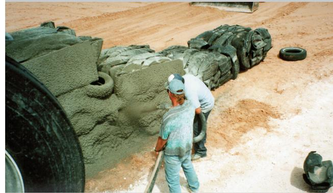
*El lanzamiento de hormigón (lanzamiento húmedo) con una mezcla endurecida y de bajo asentamiento es solo uno de los diversos usos para la bomba de hormigón LS600.*
