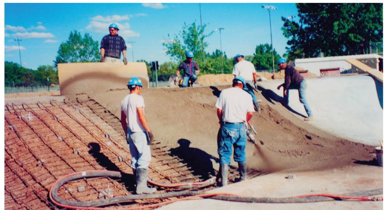
El lanzamiento de hormigón (lanzamiento húmedo) con una mezcla de hormigón lanzado endurecido y de bajo asentamiento es un día laboral común para la C30HD de Mayco.
