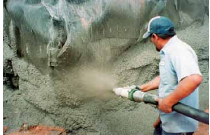
La serie C-30HDN es ideal para aplicaciones lanzado de concreto de mezclas endurecidas y bajo asentamiento: piscinas, revestimientos de zanjas, estabilización de suelo, paredes, etc.
