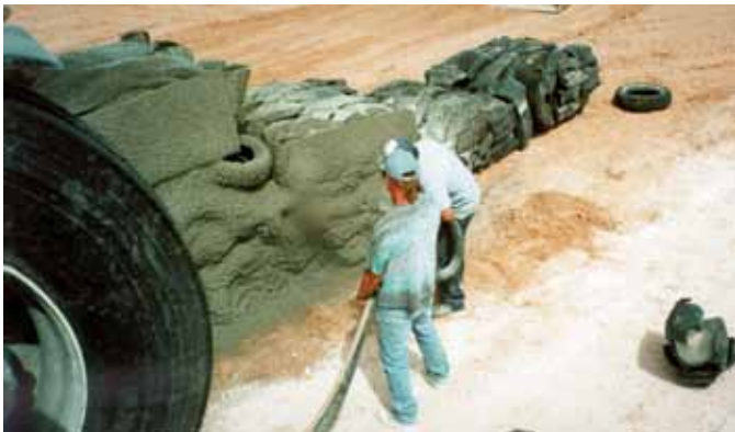
El lanzado de concreto (lanzado húmedo) con una mezcla endurecida y de bajo asentamiento es solo uno de los diversos usos para la bomba de concreto LS600.
